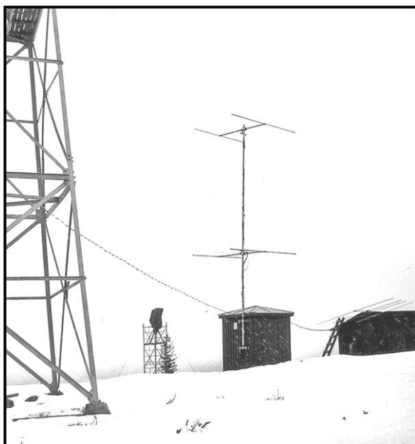
Brandtornet tv i vars topp en antenn liknade den som den som syns på det lilla apparat- husets tak var monterad. På den lilla "masten" sitter TV-länken mot Skellefteå .
